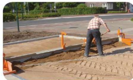
5,5 metros são nivelados com precisão entre a sarjeta e o meio-fio
