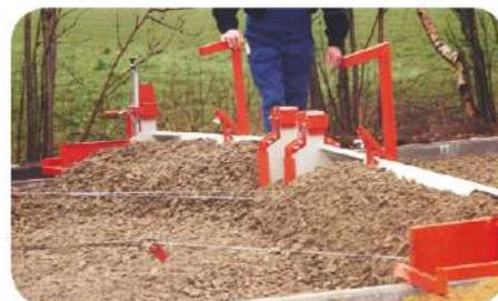
Instalação de cascalho em uma estrada com elevação central (perfil de telhado)
